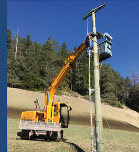
Al vëgn tut jö la cabina vedla da Pespach
