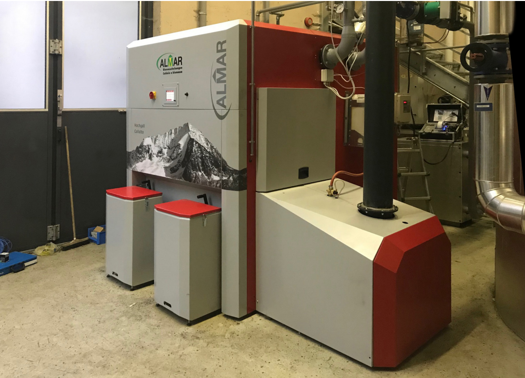
La nōia cialdira a lēgna dla marca Almar da 499kW se pormēt da scialdē plü efiziēt cun cotan de sparagn.
