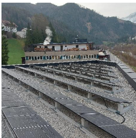
Sön le têt y la falzada dla sënta nöia el gnü instalé n fotovoltaich da 38,17 kWp
