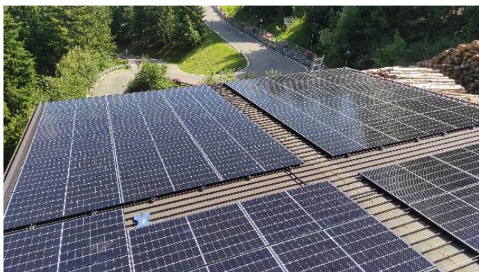
Sön le têt dl tealscialdamënt a Antermëia el gnü instalé n fotovoltaich da 28,7 kWp
