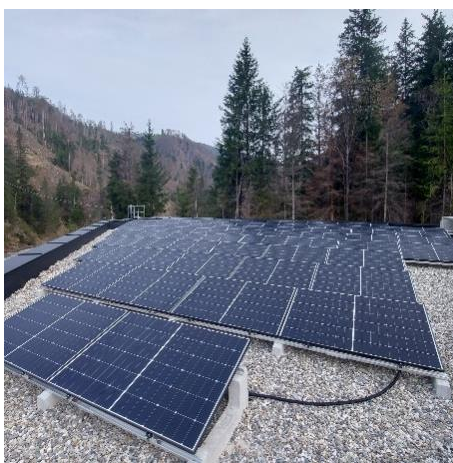
Sön le têt y la falzada dla sënta nöia el gnü instalé n fotovoltaich da 38,17 kWp
